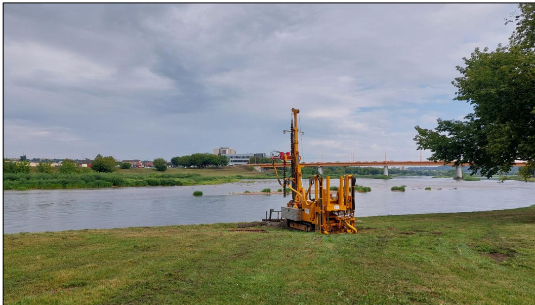
Pav. 1 Gręžimo agregatas MWG-6 gręžimo taške Gr.DZ-4 Aut. Tomas Mačiulis)
